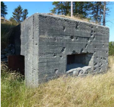
Norskbygd bunker fra 1940 – Ølberg Strandhager (Trælen) (Gnr.20 / bnr. 22). Kilde: Sola kommune.
