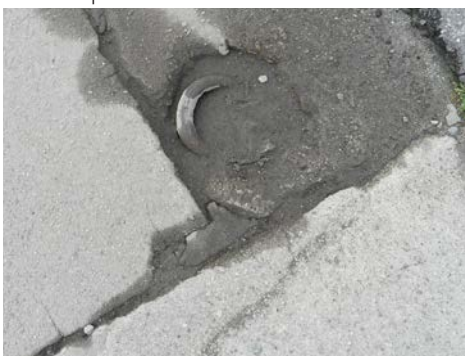
Feste i betongdekket som flyene ble festet i. Kilde: Asplan Viak.
